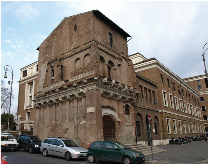
Fig. 9. Rome, Casa dei Crescenzi (photo: Kinney)
